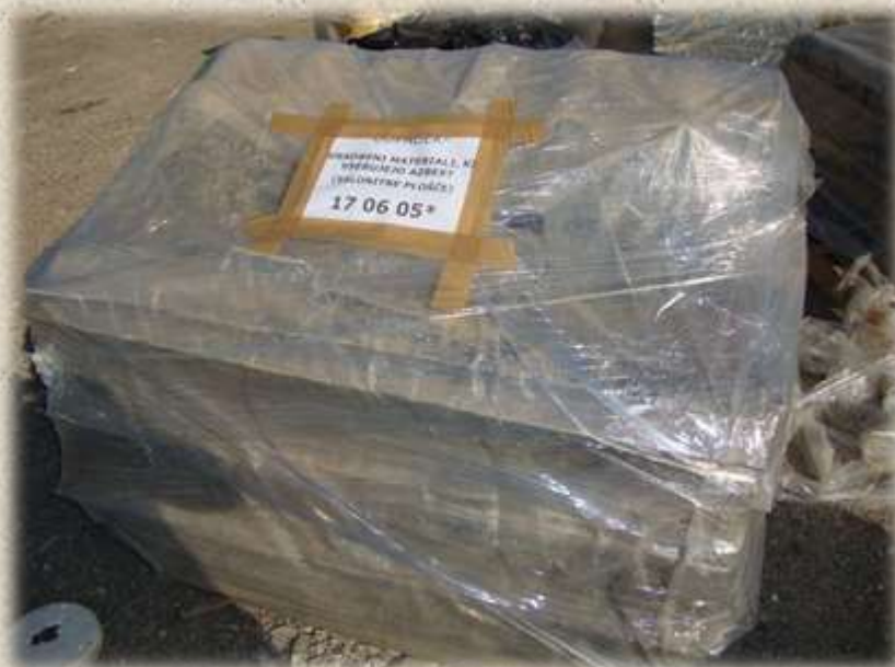
Slika 1: Pravilno ovite in pripeljane salonitne plošče
